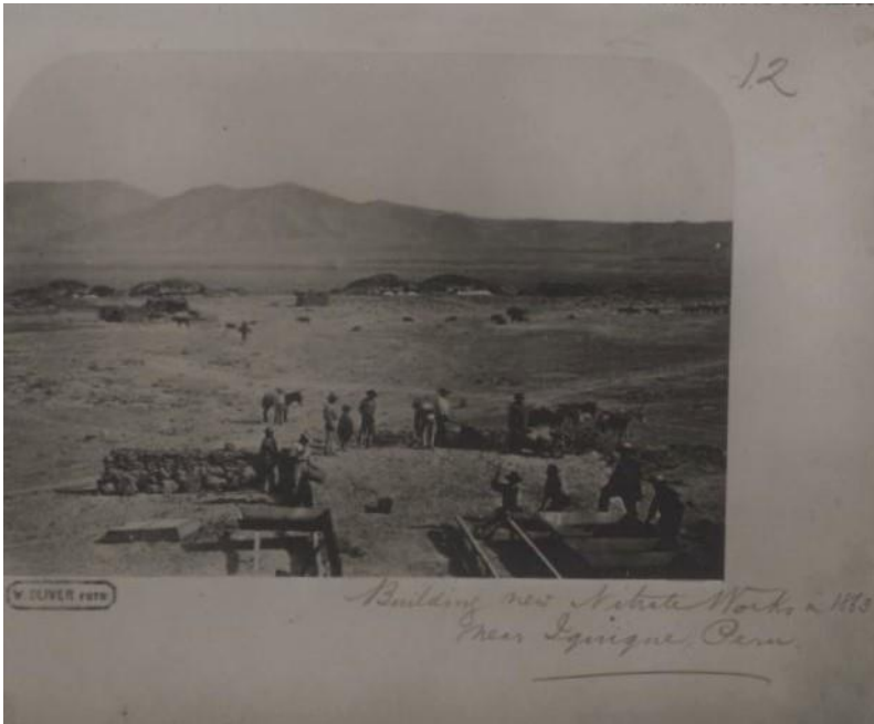
Oficina Democracia en construcción
